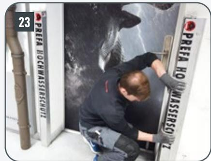
Abdeckung der Wandprofile falls vorhanden (**OPTIONAL**) montieren und gegebenenfalls mit der Schraube sichern.
