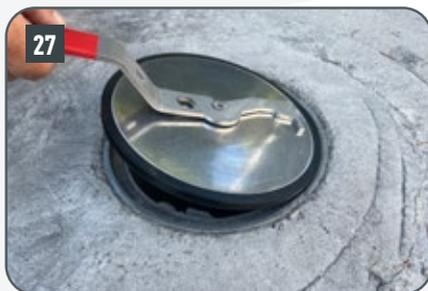
ALTERNATIV nicht verriegelbaren Deckel (**1 Schraube**) öffnen:
