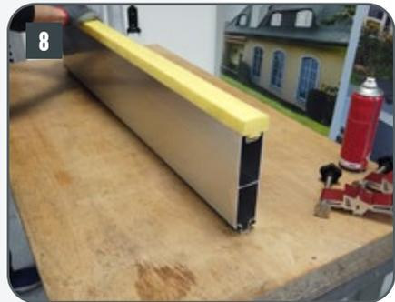
Bodendichtung mit beidseitigem Überstand in den Dammbalken eindrücken.
