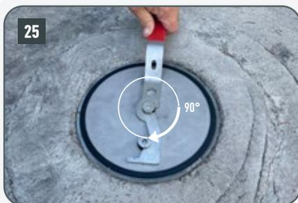
Verriegelbaren Deckel (**2 Schrauben**) öffnen:
