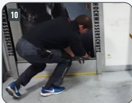
Als erstes den Dammbalken mit Bodendichtung von oben schräg in die Wandprofile einschieben und danach mit den weiteren Dammbalken fortfahren. Die Dammbalken dabei so positionieren, dass der Abstand zum Wandprofil auf beiden Seiten gleich ist.
