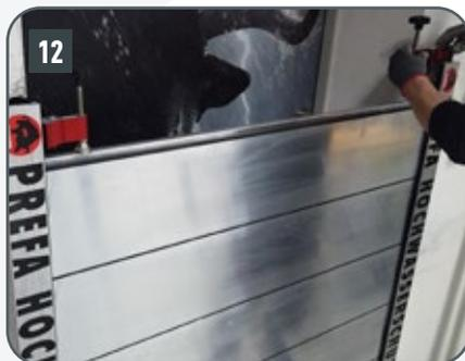
Nach dem obersten Dammbalken beidseitig das Spannstück von oben in die Nut einführen.
