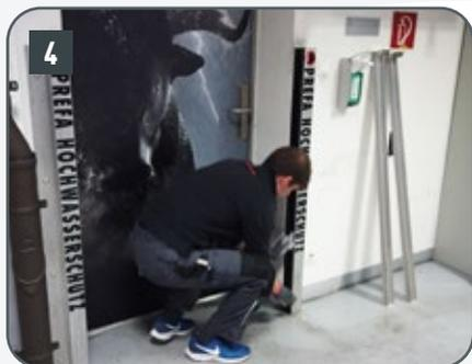
Reinigen der Profildichtung.
